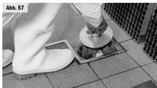
Abb. 57 2. Ziehen Sie den Überlaufstopfen, damit die Flüssigkeit abläuft.
