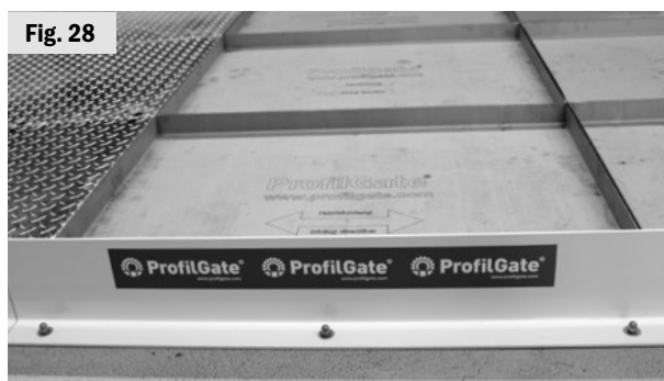
6. Visser les pattes de fixation latérales dans le sol.
