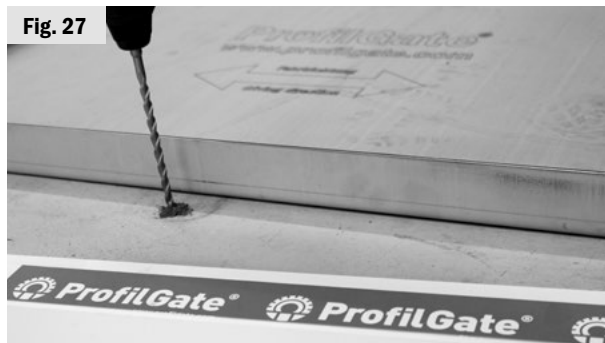
5. Préparer le vissage des angles de fixation.
